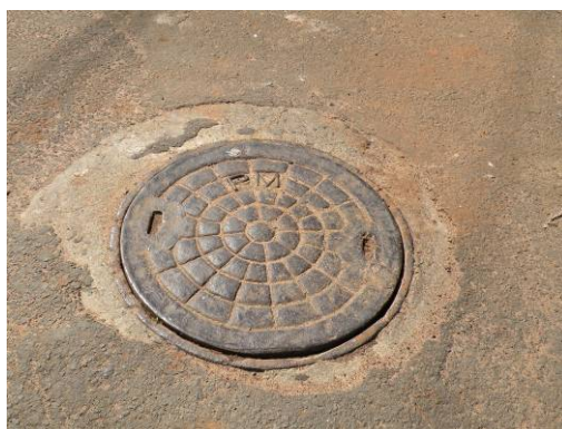
Figura 278 – Tampão de Poço de Visita típico (no centro da rua) do sistema de esgotamento sanitário de Porto Ferreira.
