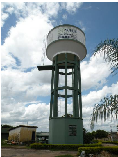
Figura 220 – Reservatório 03 da ETA-01.
