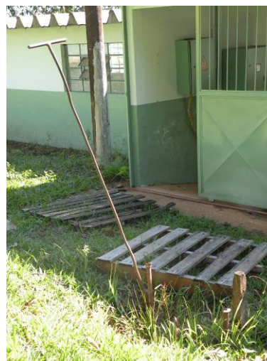
Figura 162 – Ponto em que estão instaladas as válvulas de manobra que fazem a derivação para o abastecimento direto a alguns bairros e mistura da água tratada na ETA-01 com a água tratada na ETA-02.
