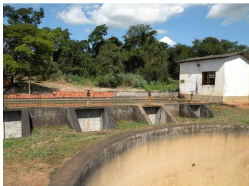
Figura 165 – Vista geral da ETA-03.
