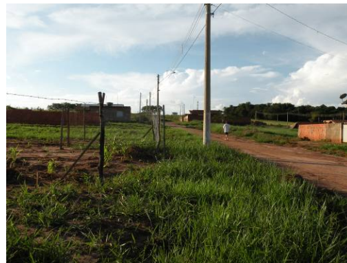
Figura 260 – Rua não pavimentada em ponto alto do bairro Vila Real que apresenta problemas de abastecimento de água.
