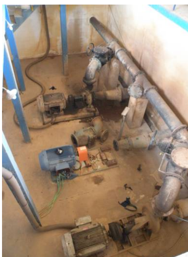
Figura 42 – Montagem das tubulações e disposição das bombas (vista 02).
