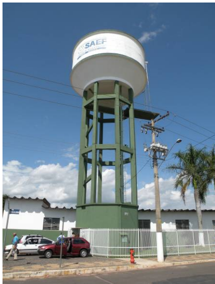
Figura 228 – Vista geral da área do reservatório.
