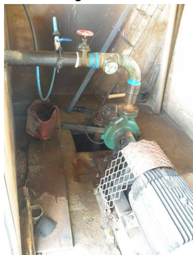
Figura 80 – Interior do poço de armazenamento de água onde está instalada a tubulação de sucção da elevatória de água bruta.
