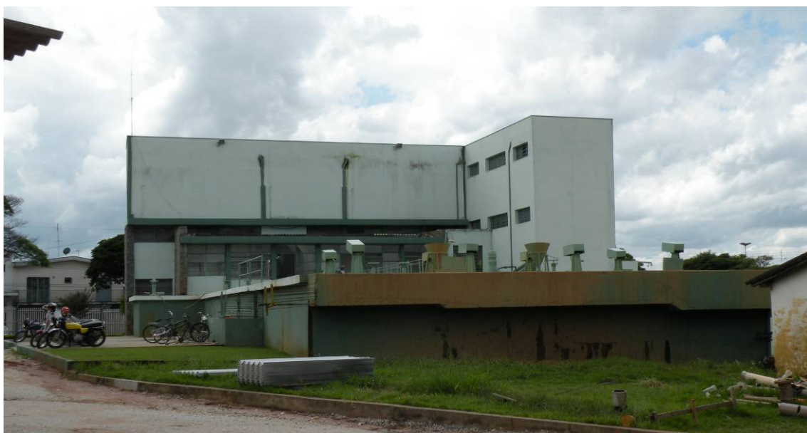
Figura 94 – Vista da ETA-01 – Prédio de administração e laboratório e unidades de tratamento.
