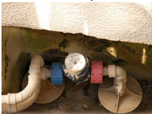
Figura 255 – Hidrômetro padrão antigo (residência na área central).
