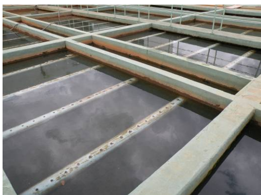
Figura 111 – Decantadores de alta taxa com módulos tubulares.
