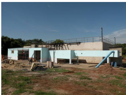
Figura 302 – Vista geral da ETE que está em fase final de construção (vista 02).
