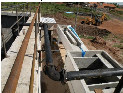
Figura 303 – Estação Elevatória que será aproveitada para alimentação do tratamento preliminar.
