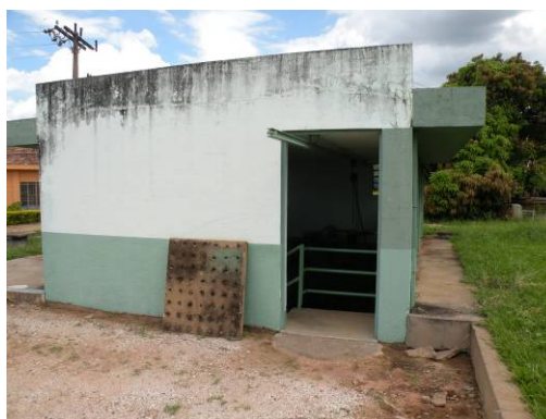
Figura 130 – Entrada da Estação Elevatória de água tratada da ETA-01.
