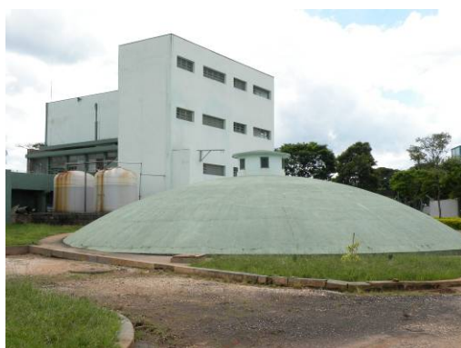
Figura 218 – Reservatório 02 da ETA-01 com prédio administrativo da ETA ao fundo.
