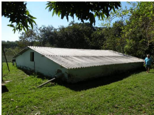
Figura 224 – Vista do Reservatório da ETA-02 (recebe grande contribuição da ETA-01).
