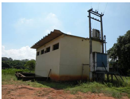
Figura 36 – Casa de bombas da parte nova da captação – vista 02.
