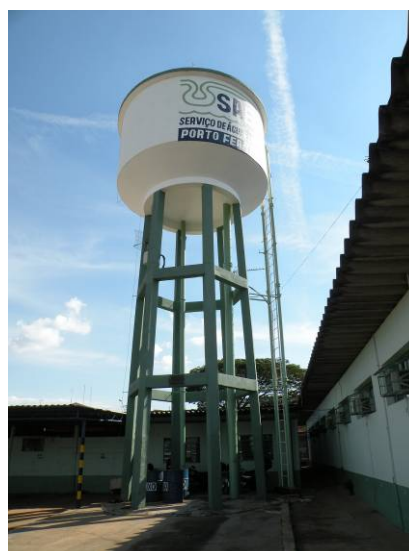
Figura 223 – Reservatório 04 da ETA-01.
