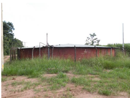
Figura 253 – Vista geral do reservatório.
