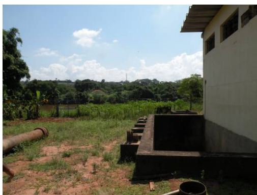
Figura 37 – Vista da casa de bombas nova com a calha do Rio Mogi-Guaçu ao fundo.
