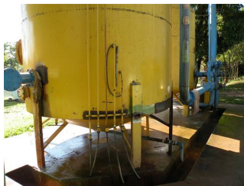
Figura 150 – Pontos de amostragem de água e pontos de vazamento no tanque e nas tubulações.
