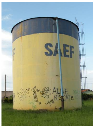
Figura 239 – Detalhe do reservatório.
