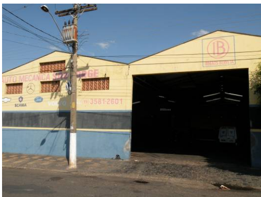
Figura 317 – Barracão que é o ponto de partida do sistema de manejo de resíduos sólidos do município (vista 01).
