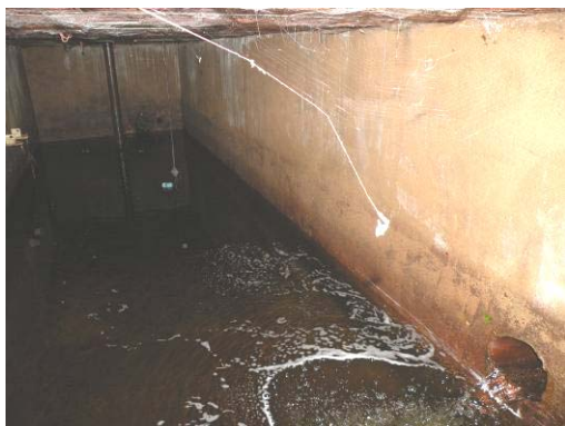
Figura 80 – Interior do poço de armazenamento de água onde está instalada a tubulação de sucção da elevatória de água bruta.
