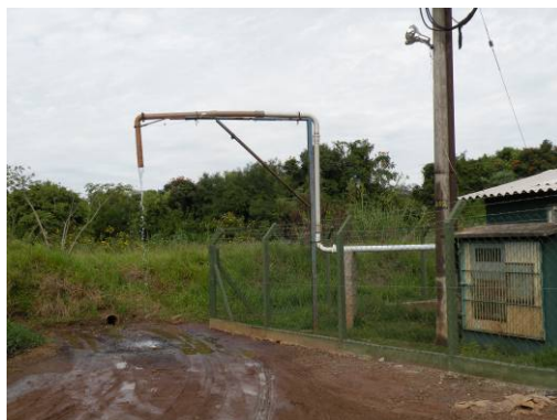
Figura 197 – Tubulação que abastece os caminhões pipa da Prefeitura com água do lago localizado junto à elevatória (água sem tratamento).
