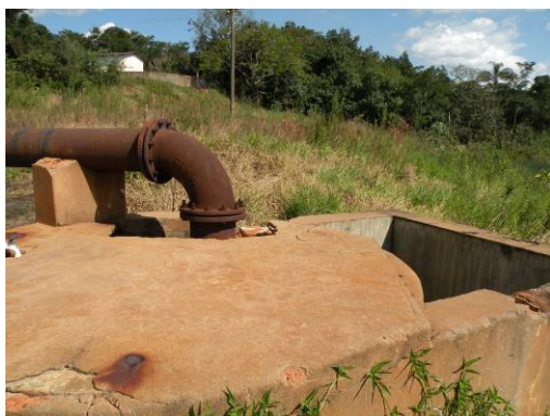
Figura 179 – Poço de sucção da água tratada.
