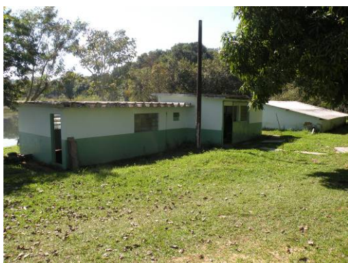
Figura 145 – Prédios da elevatória de água bruta para alimentação da ETA, da elevatória de água tratada (misturada com água vinda da ETA-01) e reservatório da ETA-02 ao fundo.
