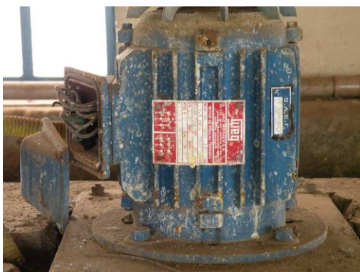
Figura 127 – Motor do sistema de dosagem de sulfato de alumínio.
