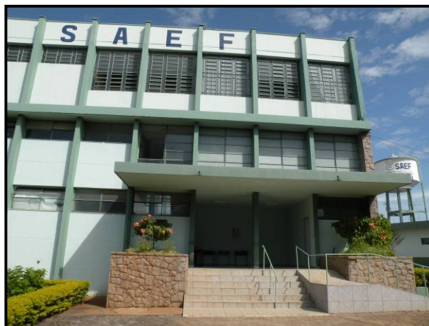
Figura 6 – Fachada do prédio administrativo da ETA Oswaldo da Cunha Leme.
