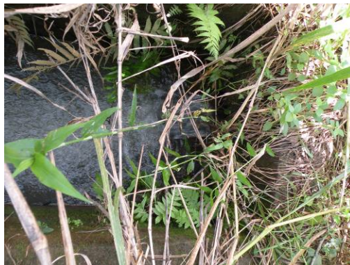
Figura 164 – Canal de chegada de água na ETA-03 (vista 02).
