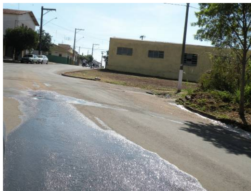
Figura 266 – Vazamento de água (vista 02).
