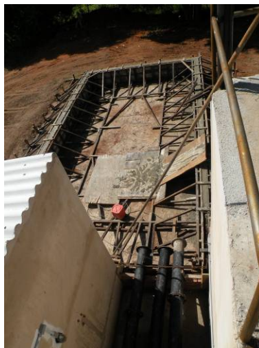
Figura 311 – Tanque de contato para desinfecção do efluente final (em construção).
