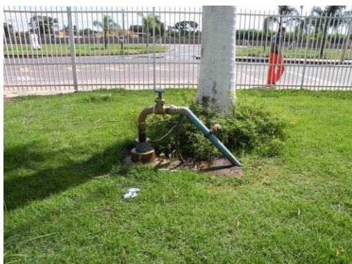
Figura 230 – Poço profundo existente na área do reservatório (vista 02).
