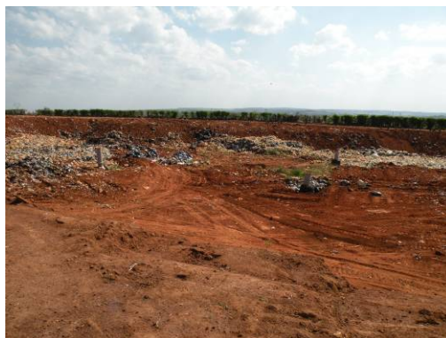
Figura 352 – Vala sendo preenchida (3ª. vala do aterro).
