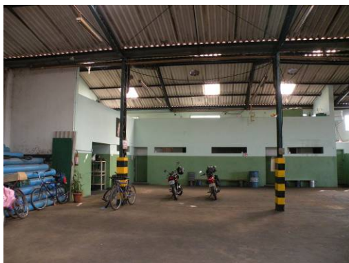
Figura 323 – Interior do barracão com salas de funcionários e vestiários ao fundo.
