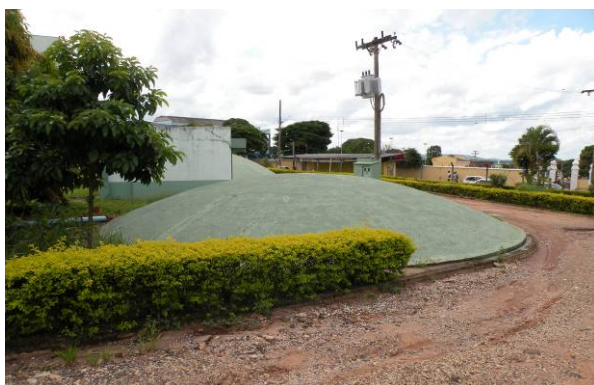
Figura 216 – Vista geral do reservatório enterrado 500 m 3 .
