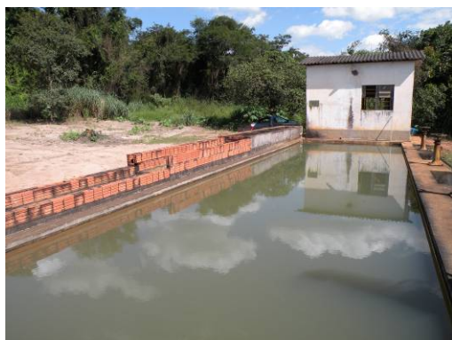
Figura 171 – Vista do decantador com a casa de química ao fundo.
