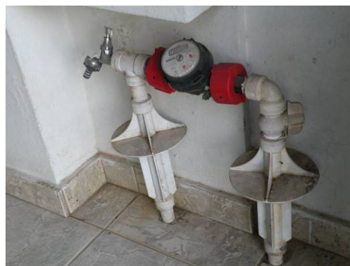
Figura 256 – Hidrômetro padrão de área central que já foi substituído.
