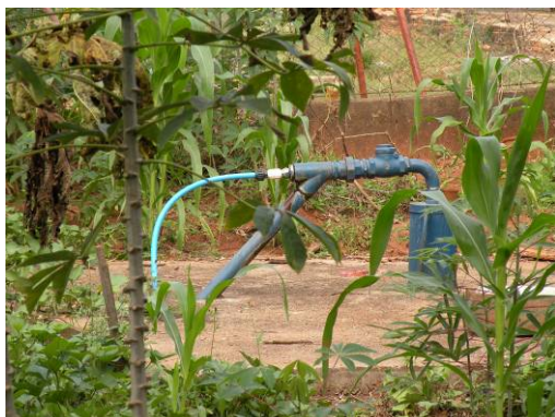
Figura 249 – Poço profundo existente na área do reservatório.
