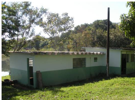
Figura 67 – Prédio da estação de bombeamento.
