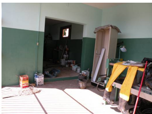
Figura 312 – Prédio administrativo e almoxarifado em fase final de construção.
