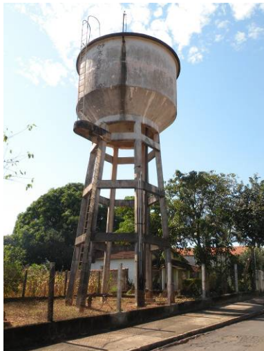
Figura 240 – Vista geral da área do reservatório (desativado).
