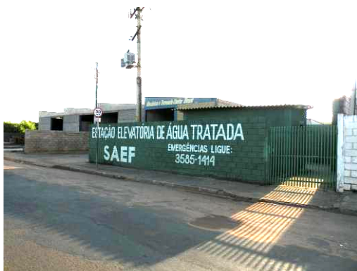
Figura 184 – Fachada da Elevatória de Água Tratada do Cristo.
