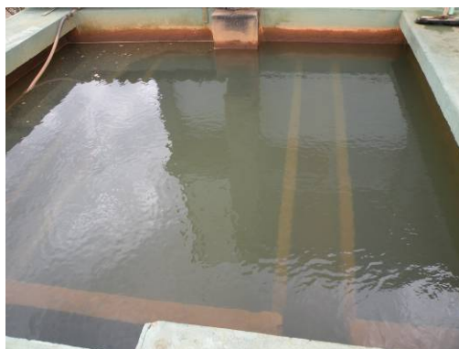
Figura 116 – Detalhe do filtro de areia e seus canais de coleta da água de lavagem dos filtros.
