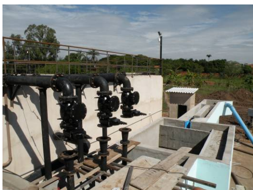
Figura 304 – Vista geral da ETE que está em fase final de construção (vista 02).
