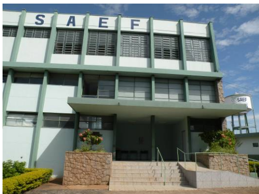
Figura 95 – Entrada principal do prédio de administração e laboratório da ETA-01.
