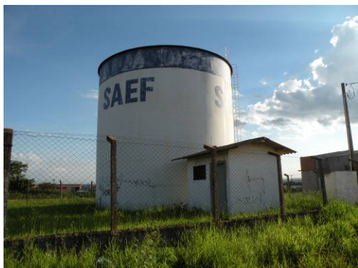
Figura 236 – Vista geral da área do reservatório e casa de bombas da elevatória Vila Real.
