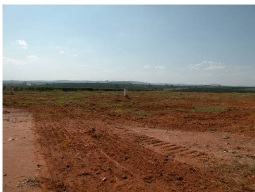
Figura 349 – Aterro sanitário municipal (vista 04 – vala já preenchida e tampada).
