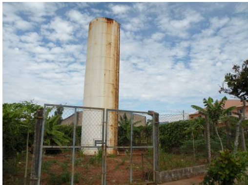
Figura 247 – Vista geral da área do reservatório.
