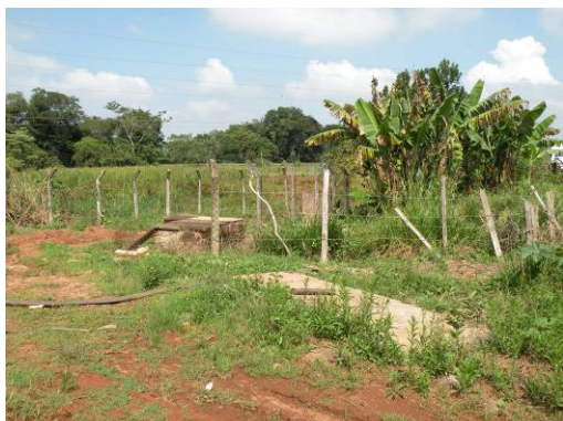
Figura 287 – Vista geral da área da elevatória.
