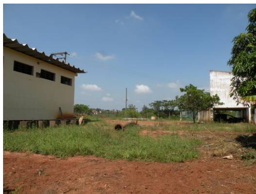
Figura 34 – Vista das estruturas da captação desde a margem do Rio Mogi.
