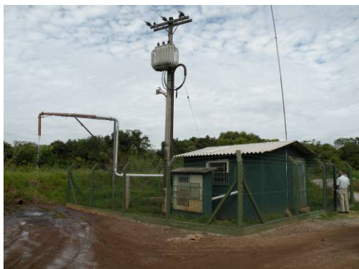
Figura 196 – Vista geral da elevatória.
