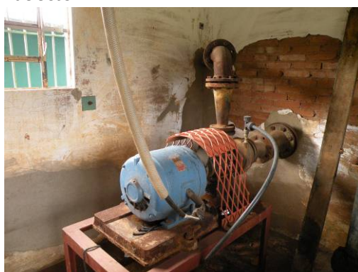
Figura 199 – Estação elevatória (casa de bombas) e tubulação de sucção do booster.
