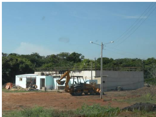
Figura 301 – Vista geral da ETE que está em fase final de construção (vista 01).
