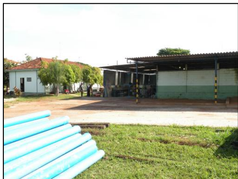
Figura 10 – Refeitório e almoxarifado do SAEF – Sede.
