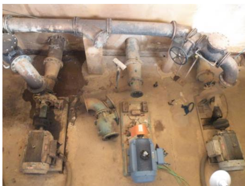
Figura 41 – Montagem das tubulações e disposição das bombas (vista 01).
