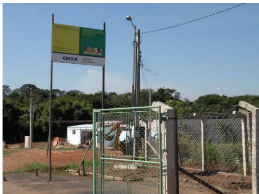
Figura 300 – Entrada da ETE Santa Rosa.
