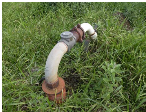
Figura 235 – Poço profundo existente na área do reservatório.
