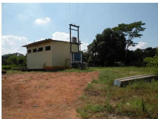
Figura 35 – Casa de bombas da parte nova da captação – vista 01.
