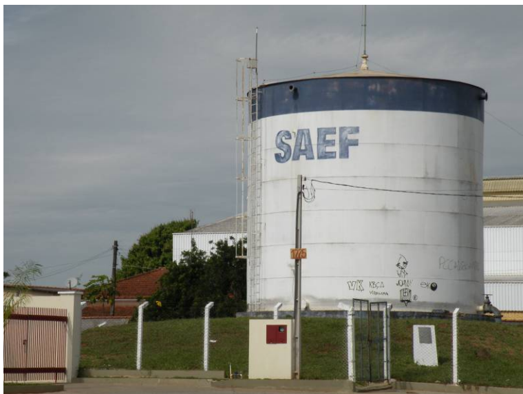
Figura 244 – Vista geral da área do reservatório.
