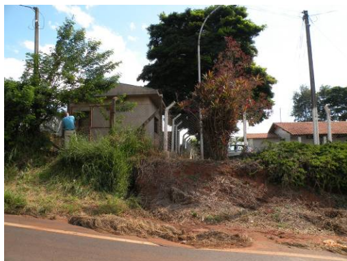
Figura 206 – Vista da área externa da Elevatória Areia Branca.
