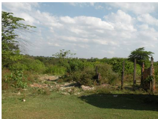
Figura 357 – Área do lixão desativado (vista 02).
