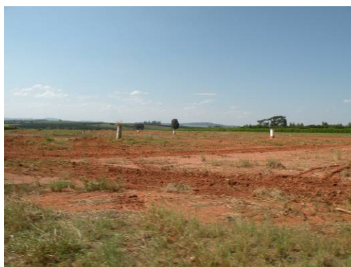
Figura 350 – Aterro sanitário municipal (vista 05 – drenos de gás ao fundo).
