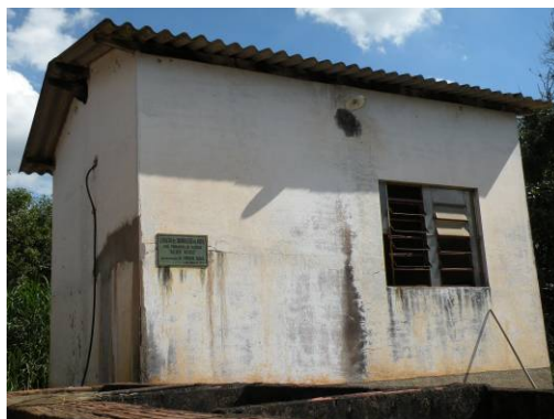
Figura 166 – Casa de química da ETA-03.
