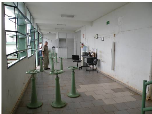
Figura 97 – Interior do prédio com volantes de manobra dos filtros à frente e laboratório ao fundo.
