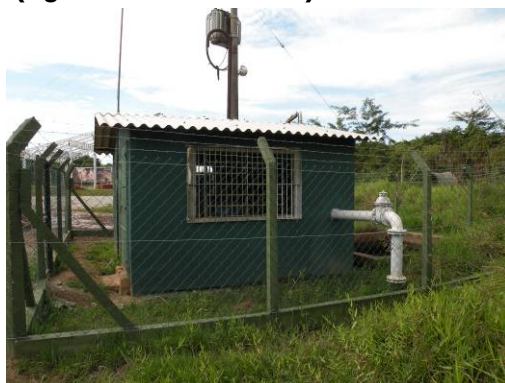
Figura 197 – Tubulação que abastece os caminhões pipa da Prefeitura com água do lago localizado junto à elevatória (água sem tratamento).
