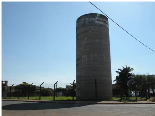
Figura 242 – Vista geral da área do reservatório.
