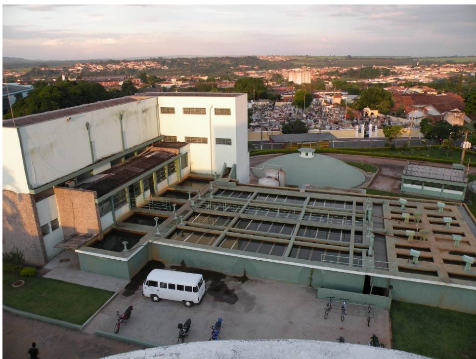
Figura 92 – Vista aérea geral da ETA-01.
