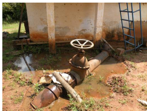
Figura 57 – Válvula de manobra da tubulação de recalque de água bruta antiga (entra em operação quando a demanda supera a capacidade da casa de bombas nova).
