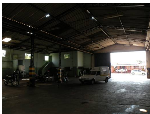
Figura 322 – Interior do barracão (vista 04).
