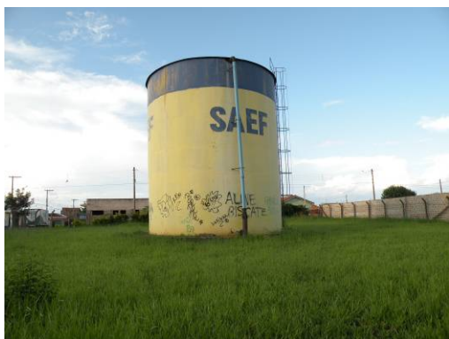
Figura 238 – Vista geral da área do reservatório
