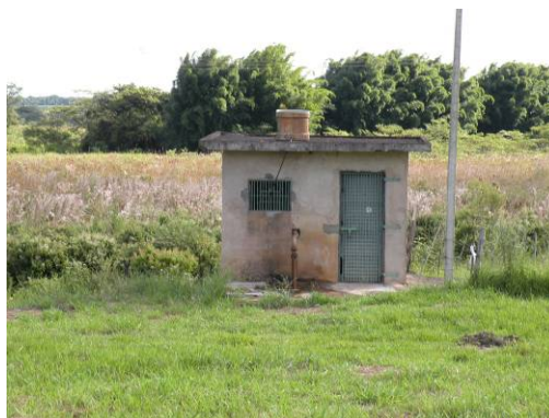
Figura 77 – Casa de bomba da elevatória de água que abastece o reservatório Cuca Fresca.
