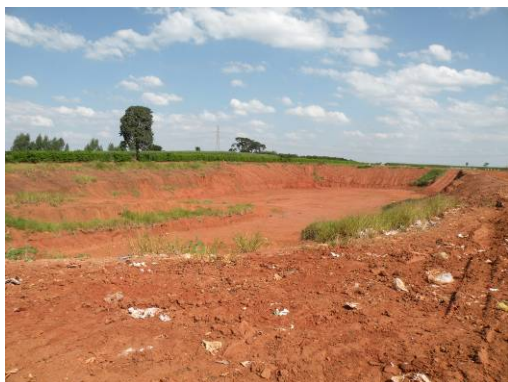
Figura 351 – Vala aberta ainda sem utilização.
