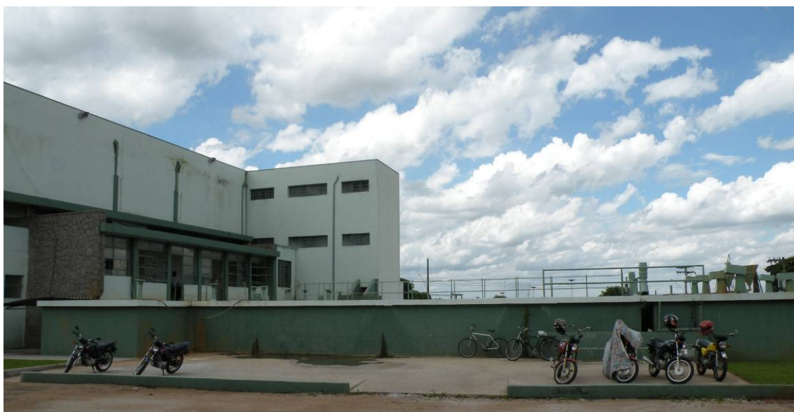
Figura 93 – Vista geral da ETA Oswaldo da Cunha Leme (ETA-01).
