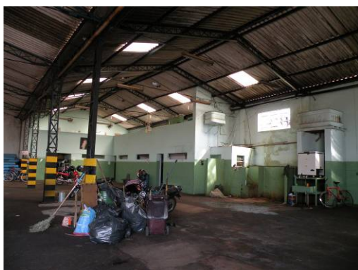
Figura 321 – Interior do barracão (vista 03).
