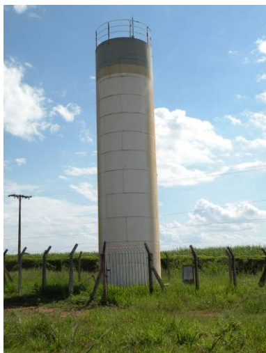
Figura 232 – Vista geral da área do reservatório.
