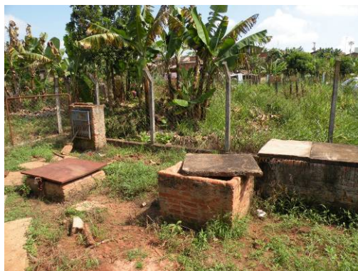
Figura 288 – Poços de chegada e de bombeamento da elevatória.
