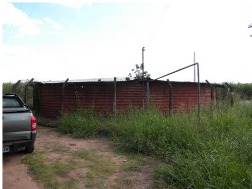
Figura 251 – Vista geral da área do reservatório e do poço.
