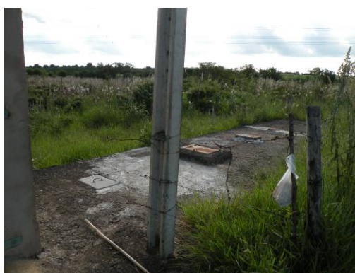
Figura 79 – Reservatório de armazenamento de água captada.
