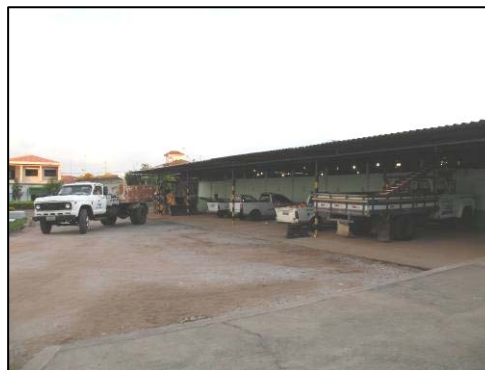
Figura 11 – Pátio de veículos e almoxarifado do SAEF – Sede.
