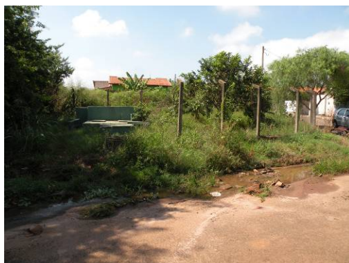
Figura 280 – Vista geral da área da elevatória.
