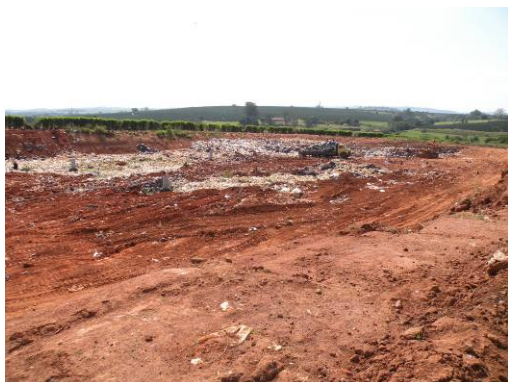
Figura 353 – Lixo recém descarregado sendo movimentado na vala (vista 01).
