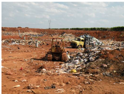
Figura 354 – Lixo recém descarregado sendo movimentado na vala (vista 02).
