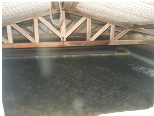
Figura 225 – Interior do Reservatório.
