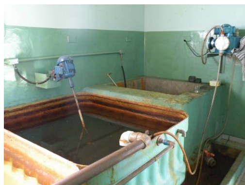
Figura 154 – Tanque de solução de sulfato de alumínio e bomba dosadora de produto.
