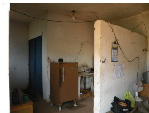
Figura 61 – Interior do almoxarifado em que ficam os vigias e operadores da captação (vista 02).
