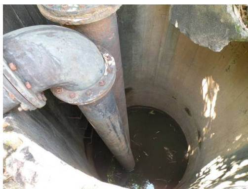
Figura 50 – Poço de sucção da captação antiga.
