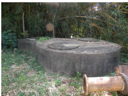
Figura 49 – Poço de visita para manutenção do canal de tomada de água da captação antiga.
