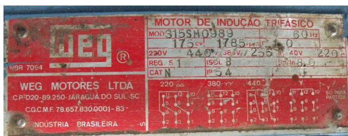
Figura 46 – Especificações dos motores das bombas
