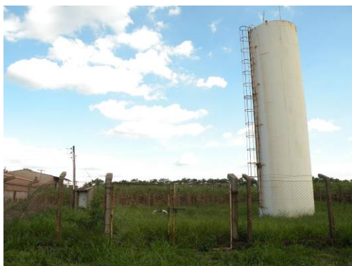
Figura 234 – Vista geral da área do reservatório
