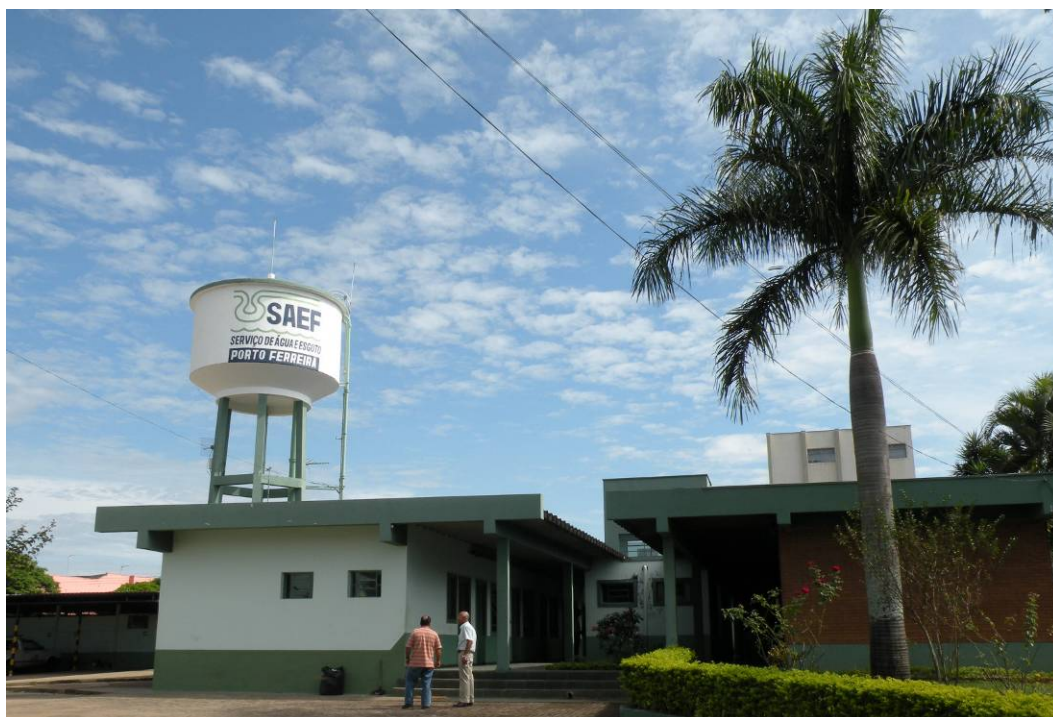
Figura 2 – Prédio administrativo do SAEF (Sede) – Porto Ferreira.
