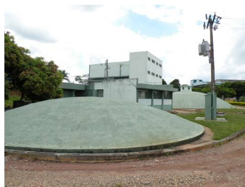
Figura 217 – Reservatório com ETA-01 ao fundo.
