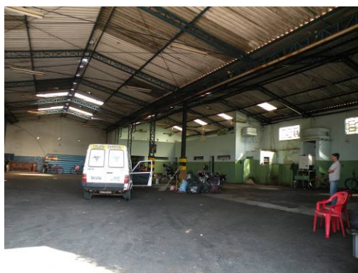
Figura 320 – Interior do barracão (vista 02).
