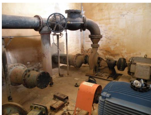
Figura 44 – Bomba em manutenção.
