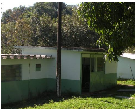
Figura 155 – Estação elevatória de água tratada da ETA-02.
