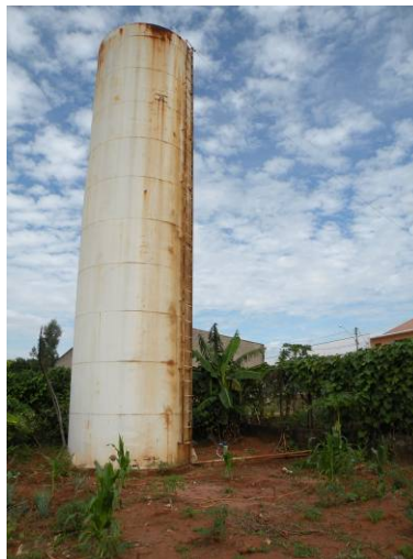
Figura 248 – Reservatório Jd. Santa Marta.
