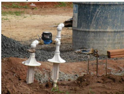
Figura 256 – Hidrômetro padrão de área central que já foi substituído.
