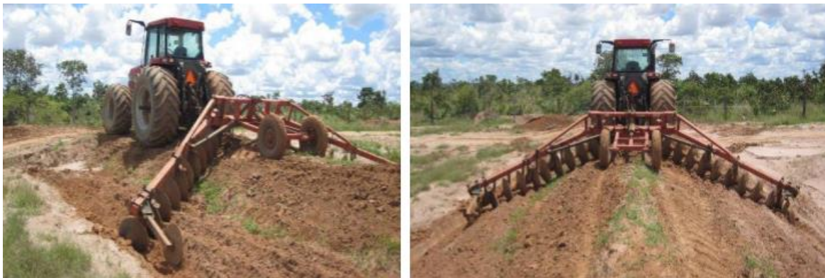
Figura 14. Construção de terraço de base larga com arado terraceador.
