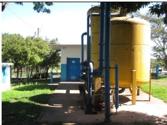
Foto 21 - Instalações da ETA 2 (ETA compacta).
