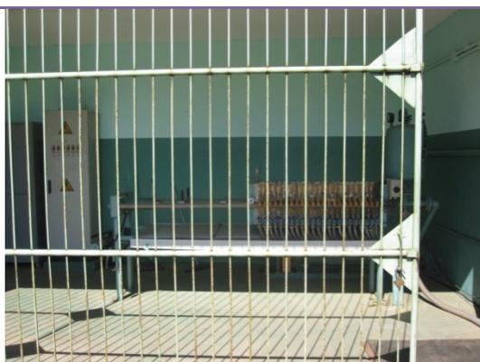
Foto 61 - Unidade de desidratação de lodo, composta por um filtro-prensa.
