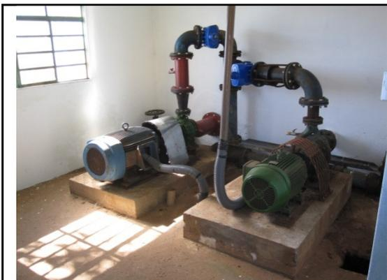
Foto 19 - Bombas da elevatória da captação nº 2.
