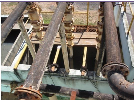
Foto 56 - Estação elevatória de efluente gradeado e desarenado que alimenta os tanques de aeração.
