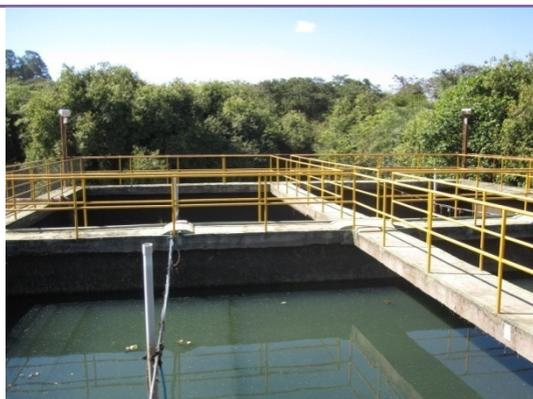
Foto 51 - Vista de um dos tanques de aerção da ETE Santa Rosa, em estágio de decantação.
