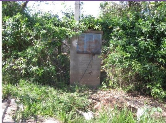
Foto 41 - Quadro de comando da estação elevatória de esgotos EEE-4E.
