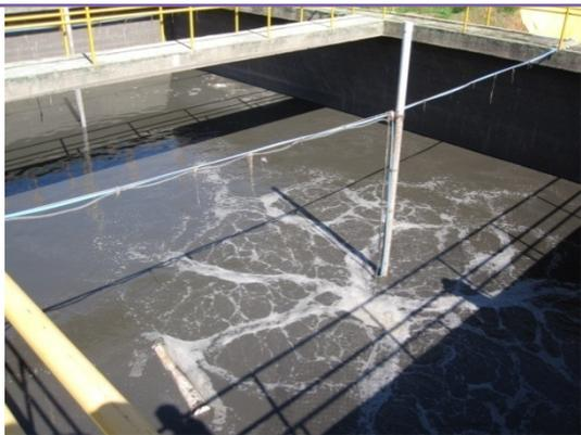
Foto 52 - Vista de um dos tanques de aeração da ETE Santa Rosa em estágio de aeração.
