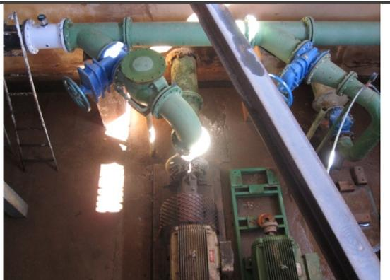
Foto 6 - Detalhe do barrilete de recalque da elevatória "nova".
