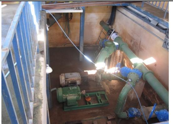
Foto 4 - Vista de um dos conjuntos de recalque da elevatória "nova".
