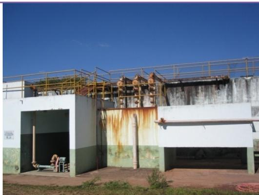
Foto 59 - Vista lateral da unidade de desarenação e gradeamento (à direita) e elevatória de alimentação dos tanques de aeração.
