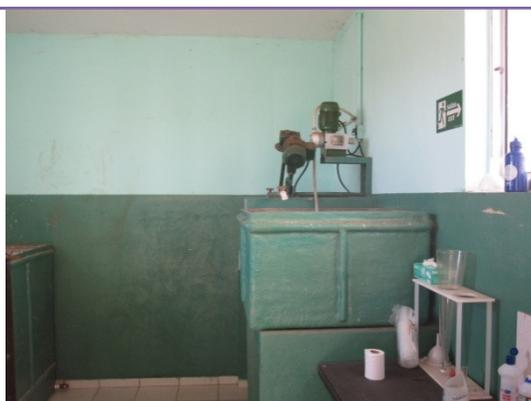
Foto 63 - Vista de um dos tanques de preparo de polieletrólito.
