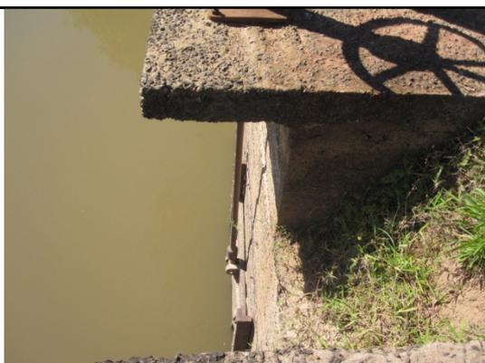
Foto 10 - detalhe da comporta da tomada de água.
