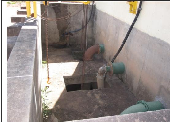
Foto 1 - Tubulações do poço de sucção da elevatória "nova" da captação nº 1 localizada no Rio Mogi Guaçu.
