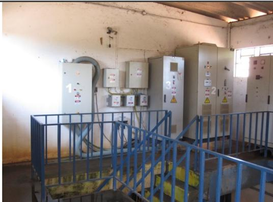
Foto 3 - Painéis das bombas da elevatória "nova" da captação nº 1.
