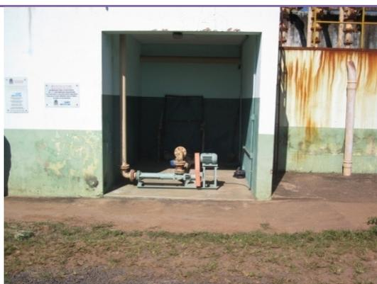
Foto 67 - Elevatória de descarte de lodo.
