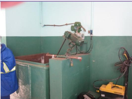
Foto 64 - Vista de outro tanque de preparo de polieletrólito.
