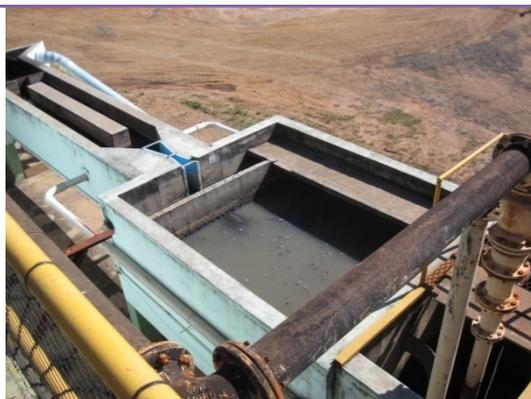
Foto 57 - Estação elevatória de efluente gradeado e desarenado que alimenta os tanques de aeração.
