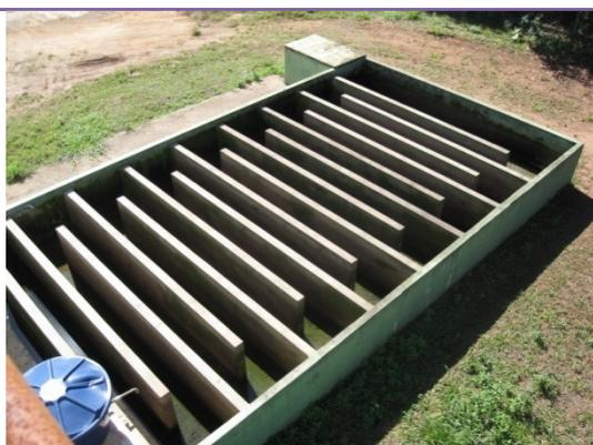
Foto 60 - Tanque de contato da unidade de desinfecção de efluente tratado.
