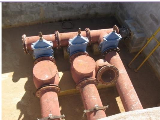
Foto 78 - Detalhe do barrilete da estação elevatória de esgoto localizada após o tratamento preliminar.
