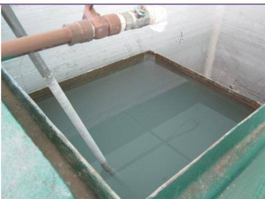
Foto 66 - Detalhe do interior de um dos tanques de preparo de polieletrólito.
