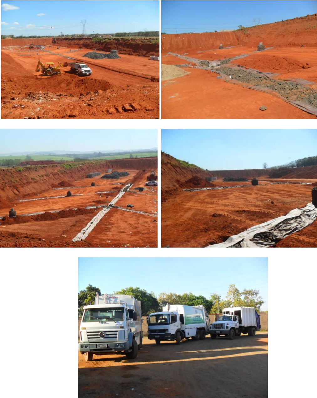
Figura 6.1 – Aterro Sanitário São Vicente. Visualização de valas abertas para início de operação e parte da frota de caminhões de coleta. Imagens cedidas pela Seção de Limpeza Pública.
