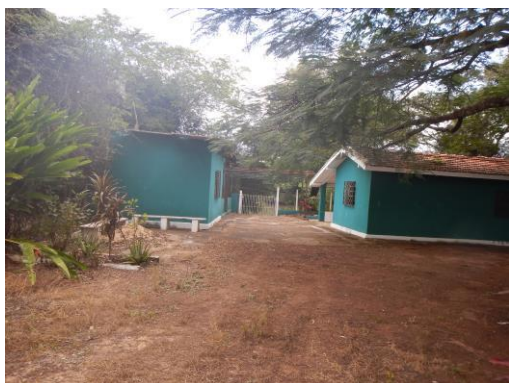
Figura 5. Moradias construídas a pequena distância da leito do Rio Mogi Guaçu.
