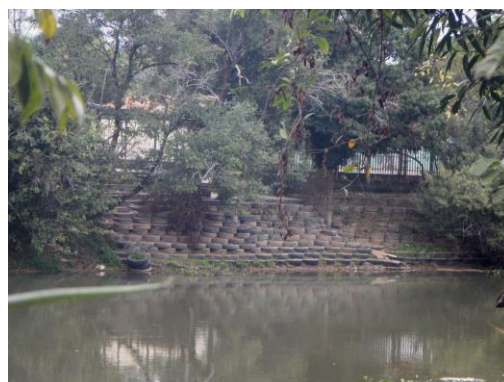
Figura 16. Barreira de pneus feita por moradores com o objetivo de diminuir os efeitos da inundação.
