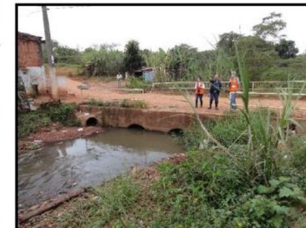
Vista a jusante da área. A travessia é composta por duas galerias meia lua, totalmente assoreadas.
