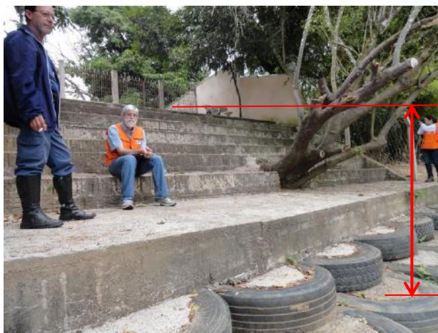
FOTO 21 - Talude marginal do rio Mogi Guaçu. Destaque para a altura do aterro executado na área.
