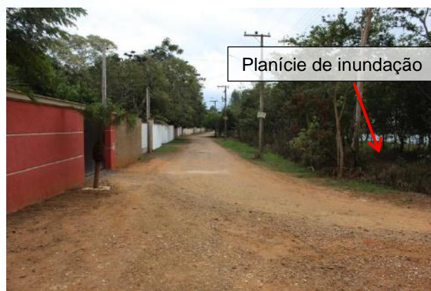
FOTO 12 - Via que é inundada durante eventos de chuvas fortes e prolongadas. Destaque para a planície de inundação ilustrada na FOTO 9 .
