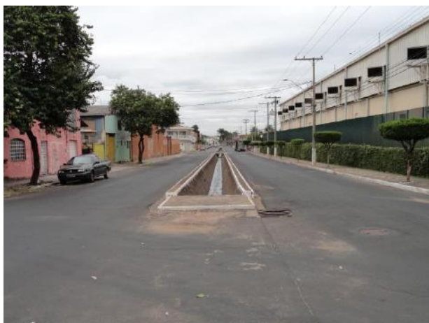
FOTO 23 - Vista geral da rua Vicente Zini, com o córrego canalizado no centro.
