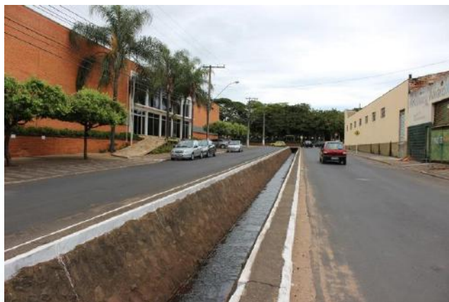
FOTO 24 - Detalhe do córrego de pequeno porte, o qual causa a inundação na área.
