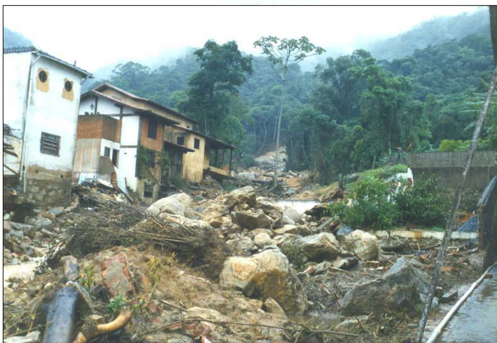
Figura 14 – Acidente associado ao processo do tipo corrida (Ministério das Cidades, Instituto de Pesquisas Tecnológicas do Estado de São Paulo – IPT, 2007).
