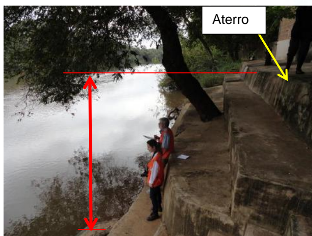
FOTO 11 - Rio Mogi Guaçu. Destaque para a altura do aterro executado no talude lateral do rio.
