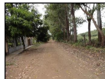
Vista geral da rua sujeita à inundação no bairro Boa Vista II.
