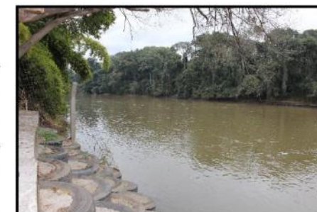
Rio Mogi Guaçu. Destaque para a contenção de pneus para evitar o solapamento do talude marginal.
