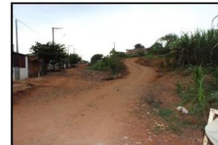
Estrada Velha de Descalvado. Destaque para a rua sem pavimentação, a qual contribui para o assoreamento do sistema de drenagem e do rio Bonito.
