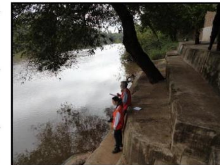
Rio Mogi Guaçu. Destaque para a altura do aterro executado no talude lateral do rio.
