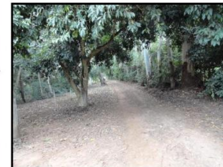
Outra vista da rua sujeita à inundação.
