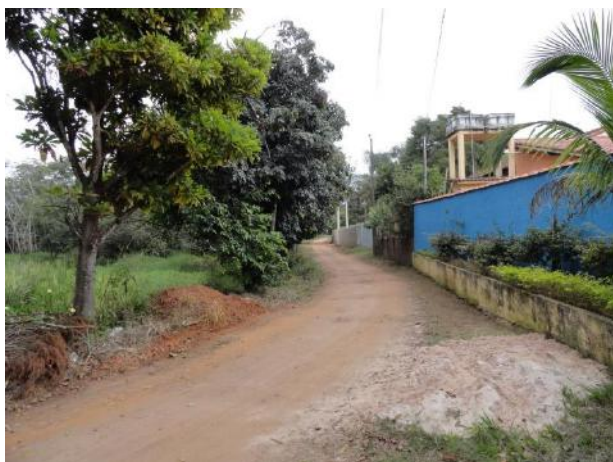
FOTO 27 - Vista geral da rua que é inundada durante os eventos de chuvas fortes e prolongadas no bairro Boa Vista I.
