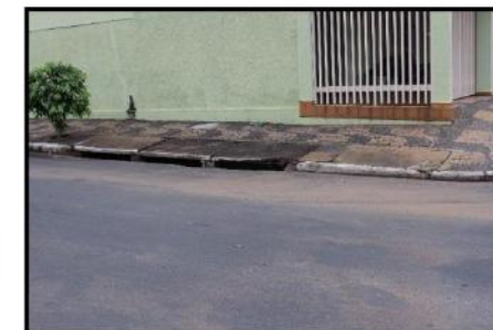
Detalhe do alteamento da moradia na rua Vicente Zini.
