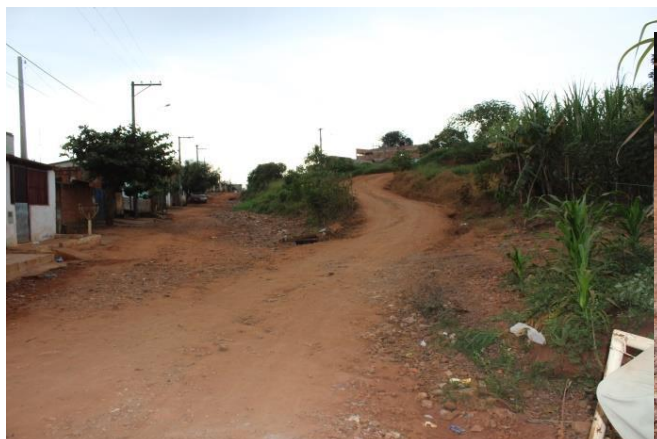
FOTO 5 - Estrada Velha de Descalvado. Destaque para a rua sem pavimentação, a qual contribui para o assoreamento do sistema de drenagem e do rio Bonito.
